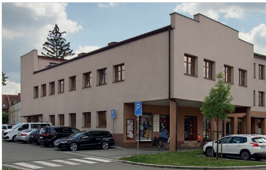
Budova, ve které je soustředěna hlavní činnost a sídlo Charity Strážnice Strážnice – ulice Kovářská 396
